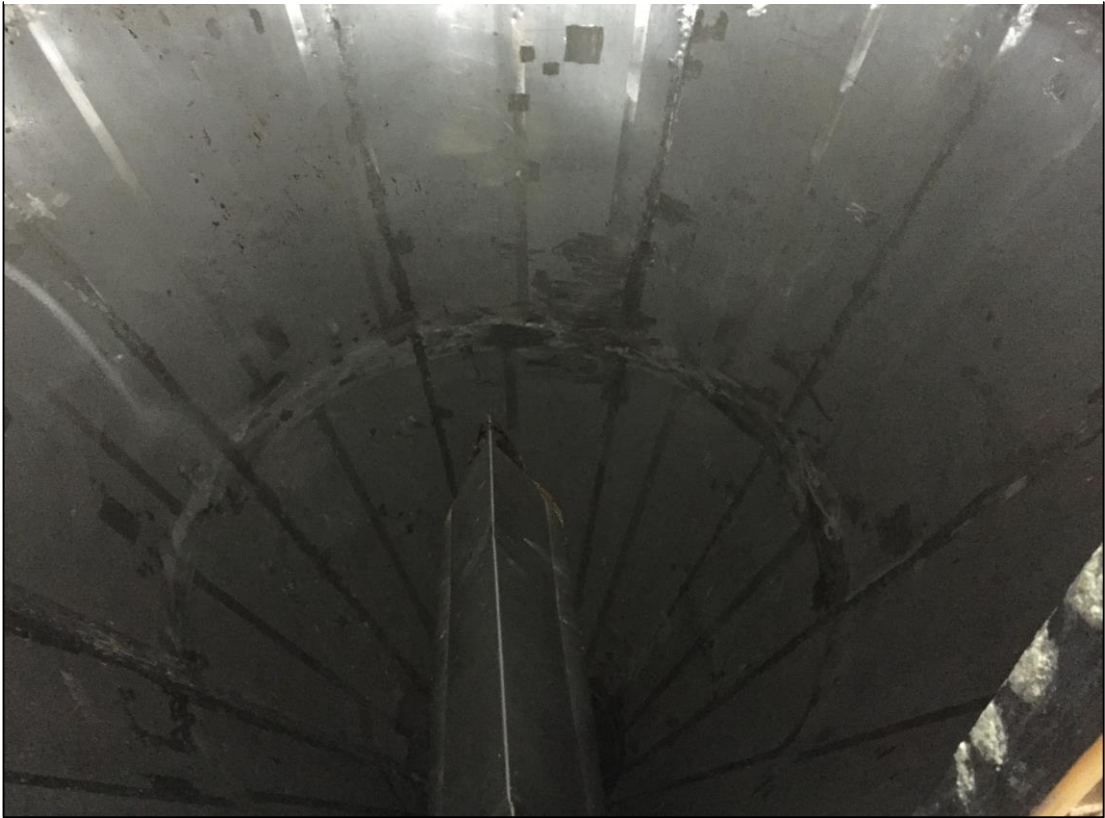
Şekil 1.24. Süt kulesi iç yüzeyi
