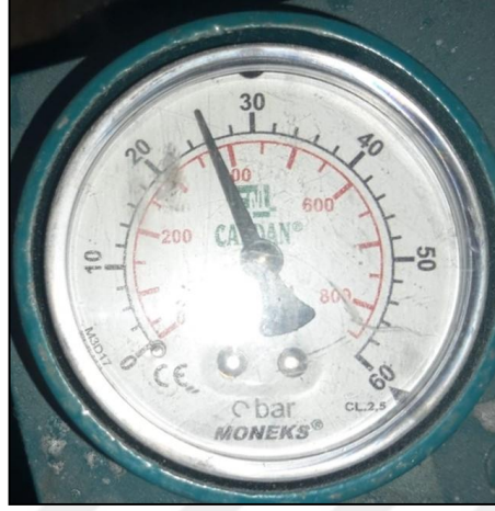
řekil 4.27. Ön ısıtma bataryası 27 bar basınç testi
