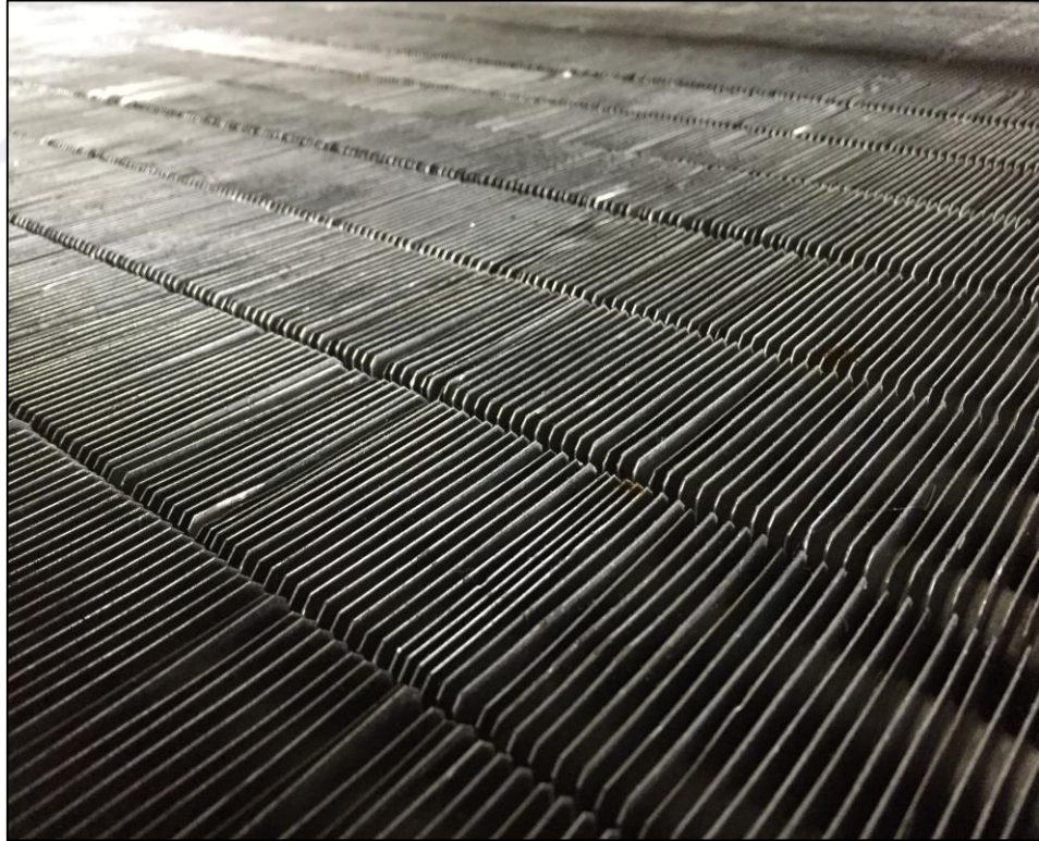
řekil 4.28. Ön ısıtma bataryası 27 bar basınç testi
