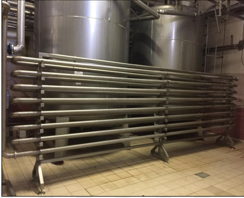
Şekil 1.15. Plakalı pastörizatör bekleme boruları
