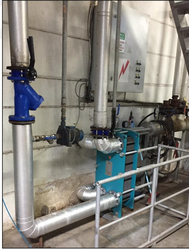
Şekil 3.2. Plakalı ısı eşanjör
