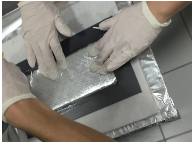
Şekil 3.4. Reçine üzerine tekrar cam elyafın yerleştirilmesi
