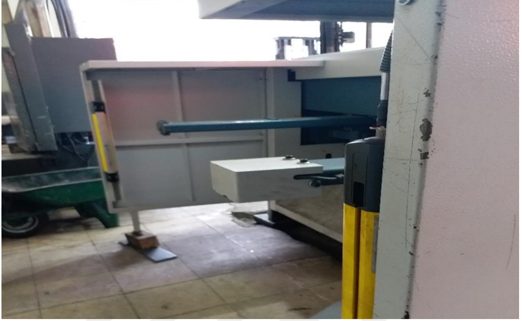
Şekil 4.10. İnterlok ile kesme alanı arkasına kişi girişini engelleyen örnek giyotin makas tezgahı (fotosel ile kısıtlı alana giren olduğunda çalışma durmakta)
