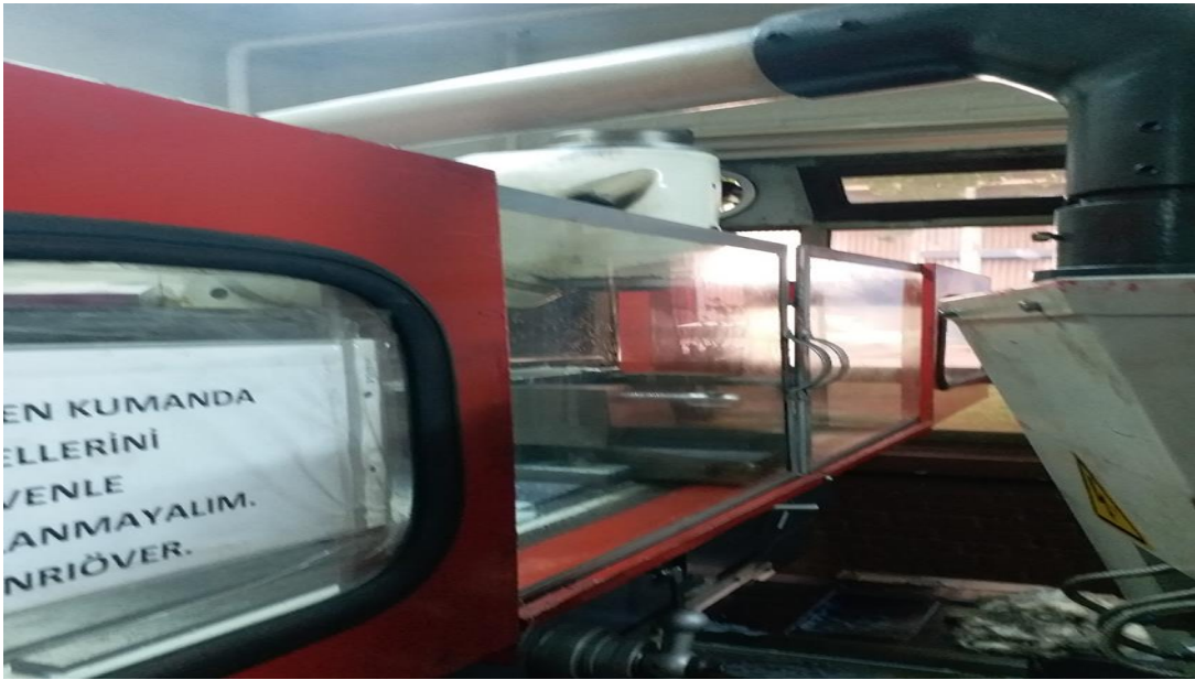
Şekil 4.5. Risk Değerlendirme sonrası hareketli, interlok olmayan şeffaf muhafaza kapısı yapılan Optimum yatay freze tezgahı
