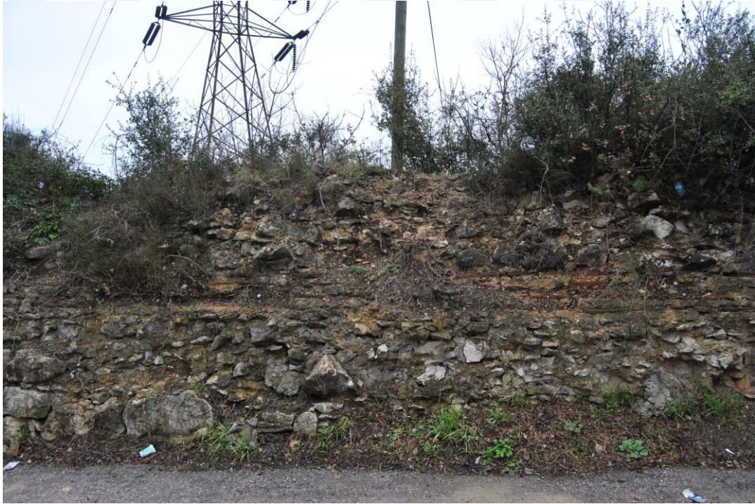
Şekil 3. 4. Kent surlarına ait duvar örgü sistemi (Aydın arşivi, haziran 2019)
