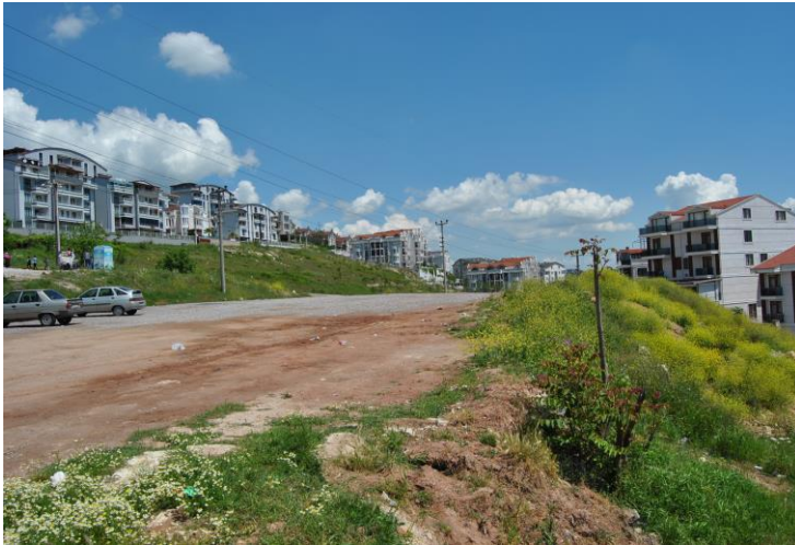
Şekil 3.35. Yenidoğan Mahallesi mevcut durumu (Aydın arşivi, haziran 2019)
