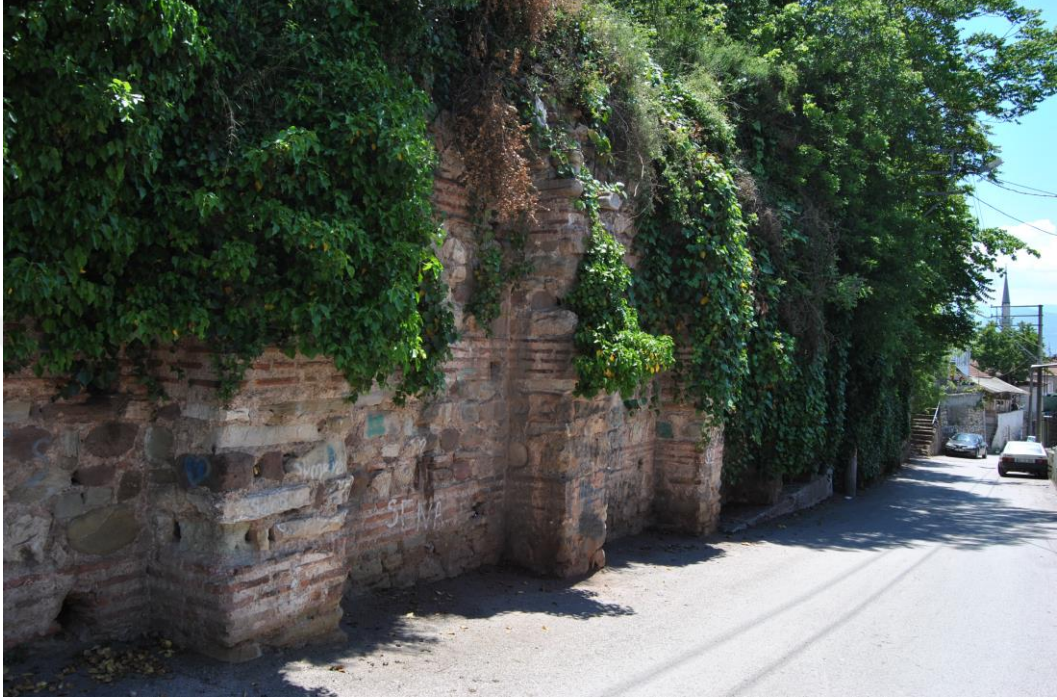
Şekil 3.38. Manastır duvarının mevcut durumu (Aydın arşivi, 2019)
