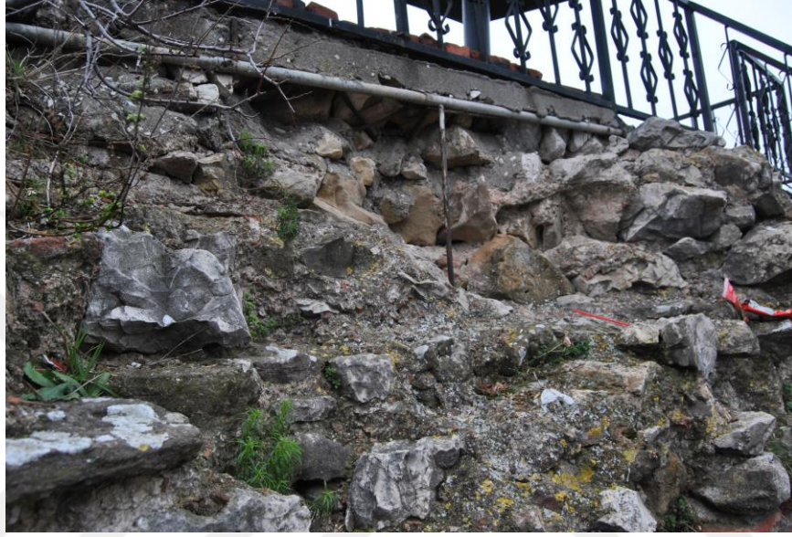
Şekil 3.26. Bayraktar Burcu mevcut durumu ve müdahale malzemeleri ile özgün yapı malzemesinin ilişkisi
