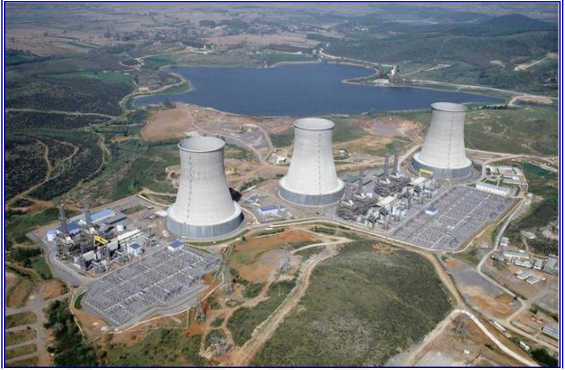
Şekil 1.3. Doğalgaz kombine çevrim santralinin görüntüsü
