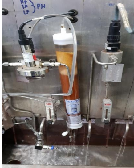
Şekil 2.6. Drumlardan gelen suya bağlanmış katyon reçine kolonu
