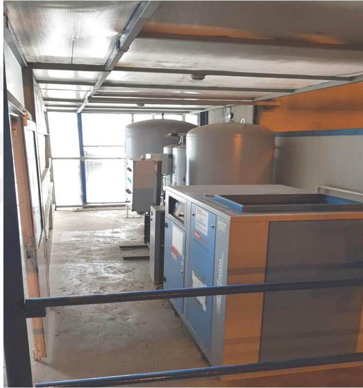
Şekil 3.11. Kurulan azot jeneratörü
