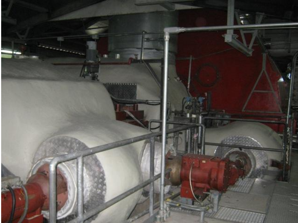
Şekil 1.8. Buhar türbini
