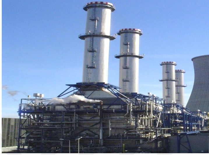
Şekil 1.6. Atık ısı kazanı
