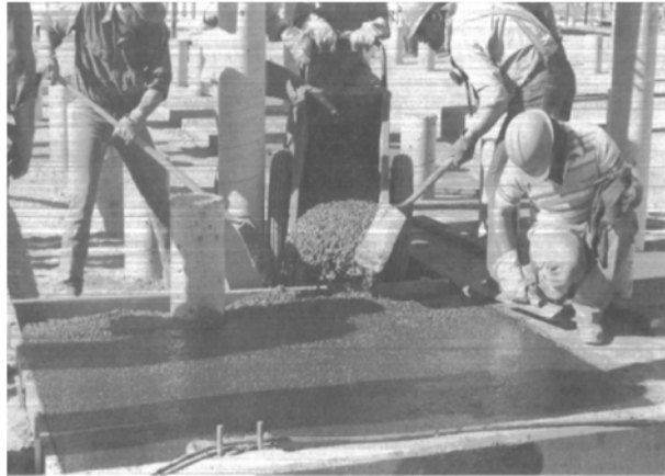
Şekil 1.19. KPB zemin betonu [50]
