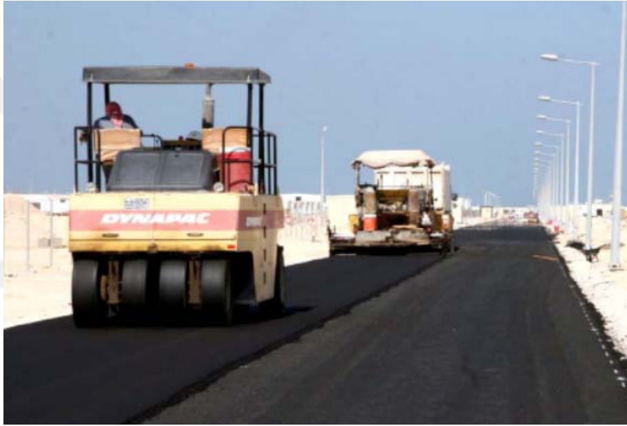
Şekil 1.23. Modifiye edilmiş kükürtlü asfalt beton uygulaması [111]
