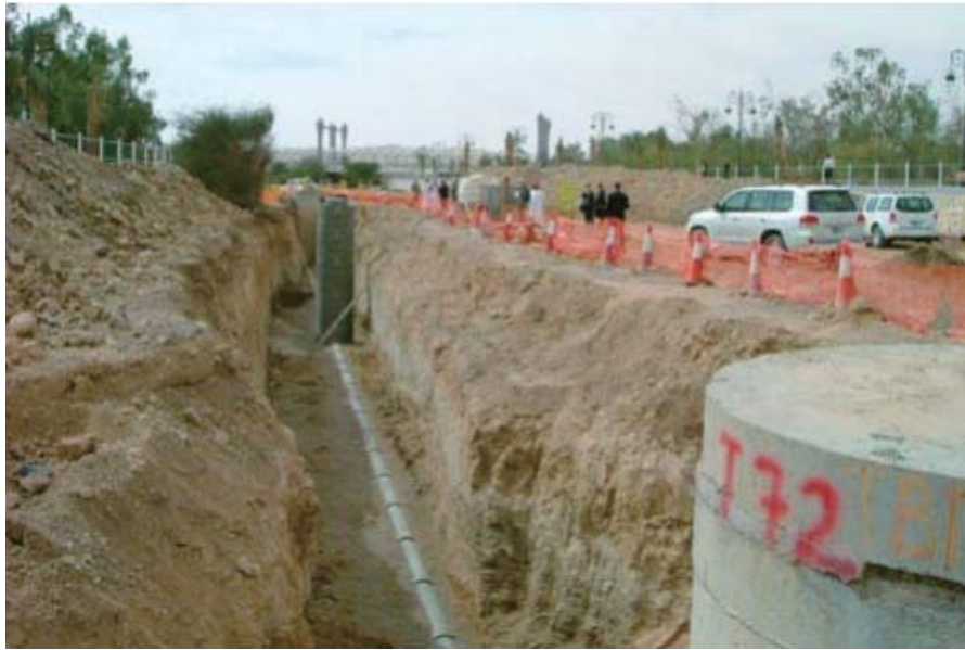
Şekil 1.22. KPB kanalizasyon hattı saha uygulaması, Al Ain, BAE [2]
