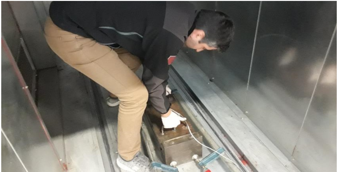
Şekil 4.8. st kalıbın kapatılması
