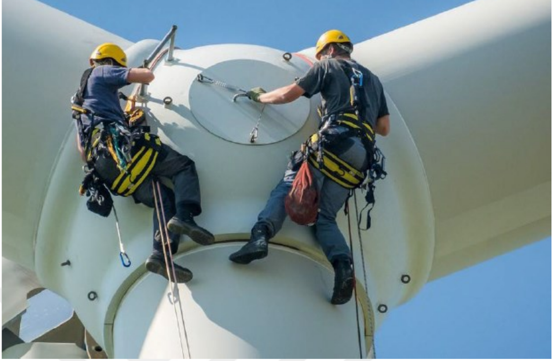
Şekil 2.4. Rüzgâr jeneratöründe askında çalışan işçiler [37]
