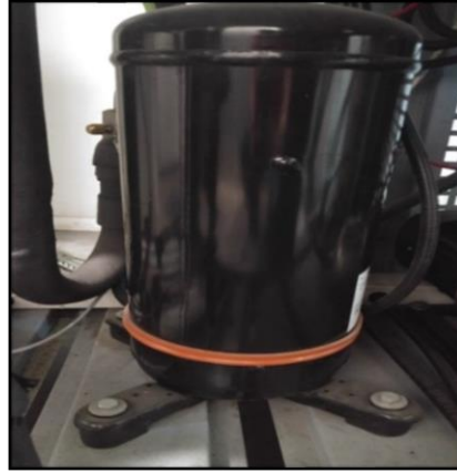
Şekil 2.1. 7 HP scroll kompresör
