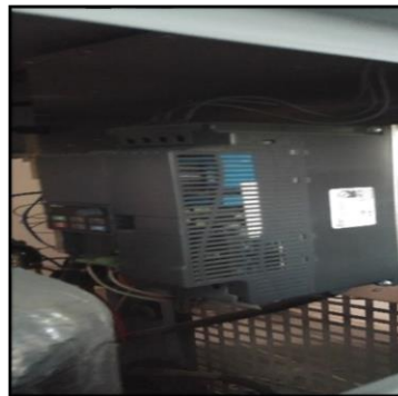
Şekil 2.17. Frekans sürücüsü
