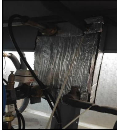
Őekil 2.3. İzolasyonlu kaynaklı tip plakalı ısı deęiřtirici
