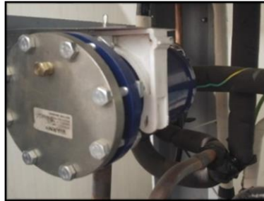
Şekil 2.10. Kartuş filtre
