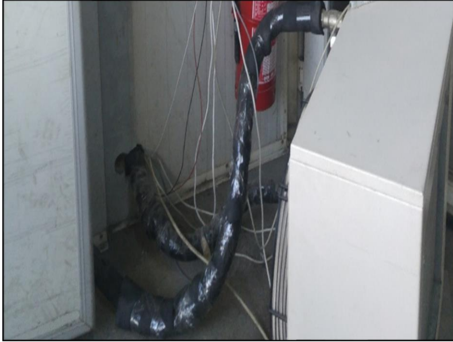
Şekil 2.26. Isı pompası ile hava aparey arasındaki bağlantıyı sağlayan kauçuk izolasyonlu 304 kalite paslanmaz çelik örgü flex hortumlar
