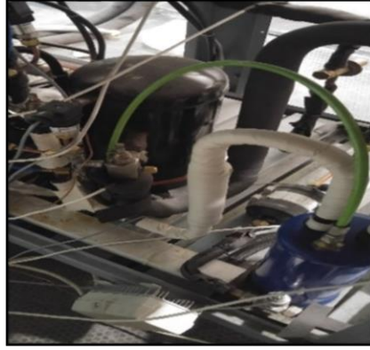
Şekil 2.8. Yağ ayırıcı
