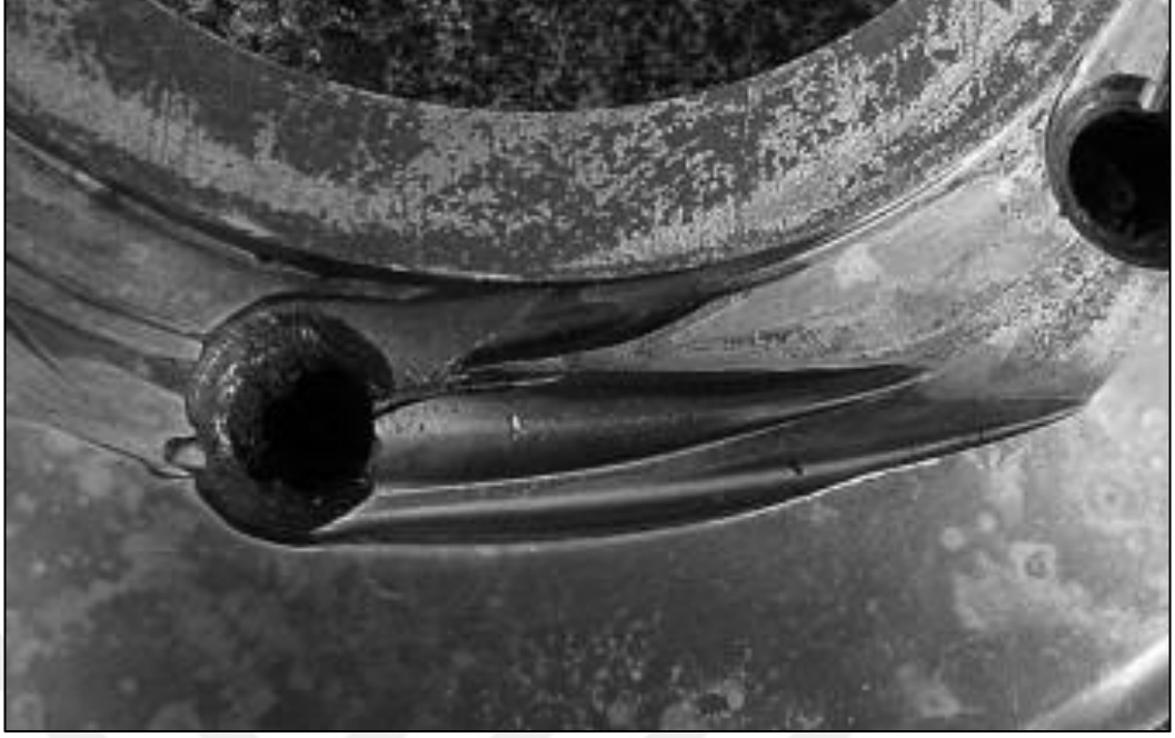
Şekil 4.4. Pompa gaz kelebeği burcunda oluşan eroziv aşınma [48].
