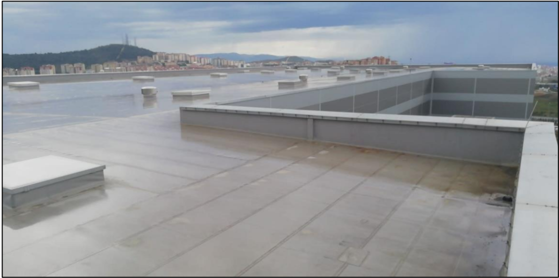
Şekil 6.3. Kurulum öncesi çatıdaki parapet görünümü
