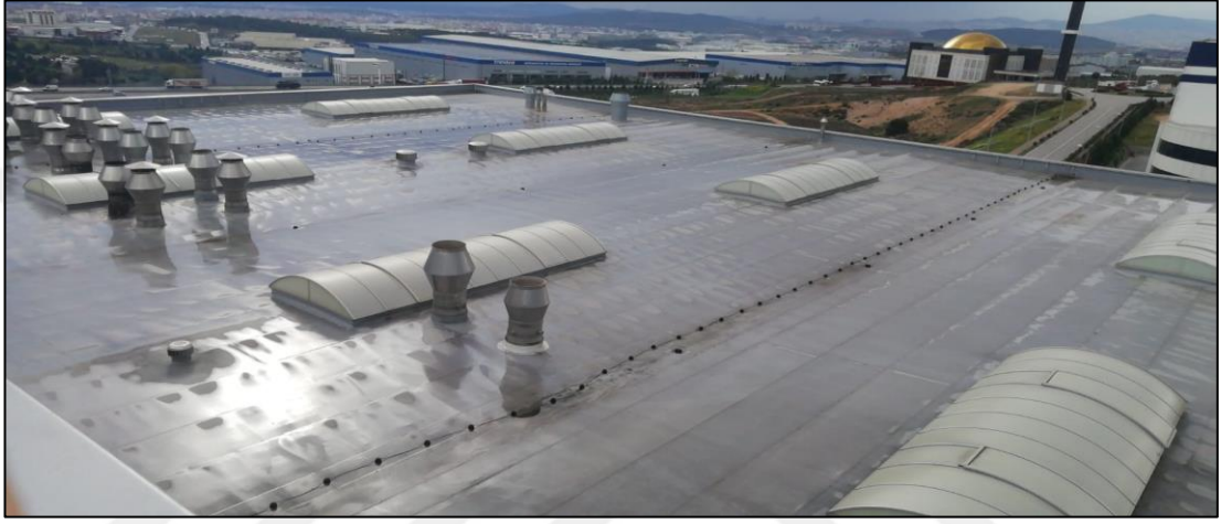
Şekil 6.2. Kurulum öncesi çatıdaki baca ve aydınlatma pencerelerinden görüntü
