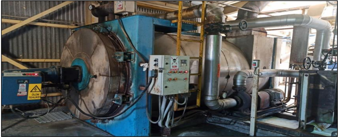
Şekil 8.4. Sıcak yağ kazanı
