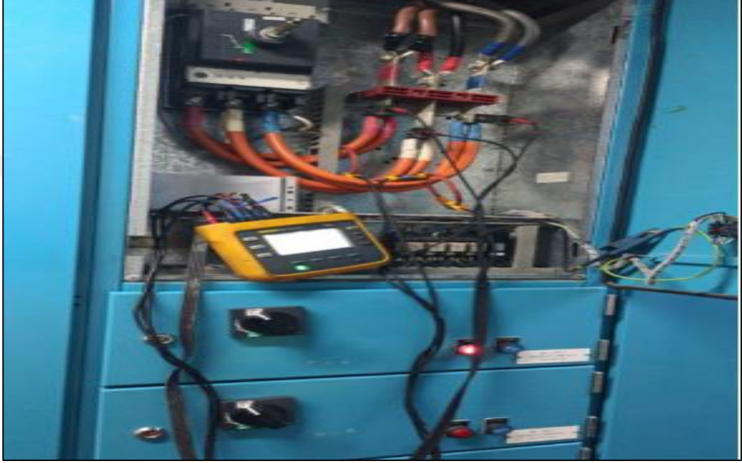
Şekil 6.8. Pompalarda aktif güç ölçümü
