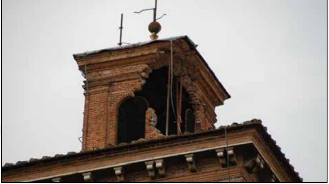
Şekil 2.11. 2012 yılında İtalya'da meydana gelen depremde hasar gören Ferrara Kalesi'ndeki kulelerden biri (UNISDR ve diğ., 2013)
