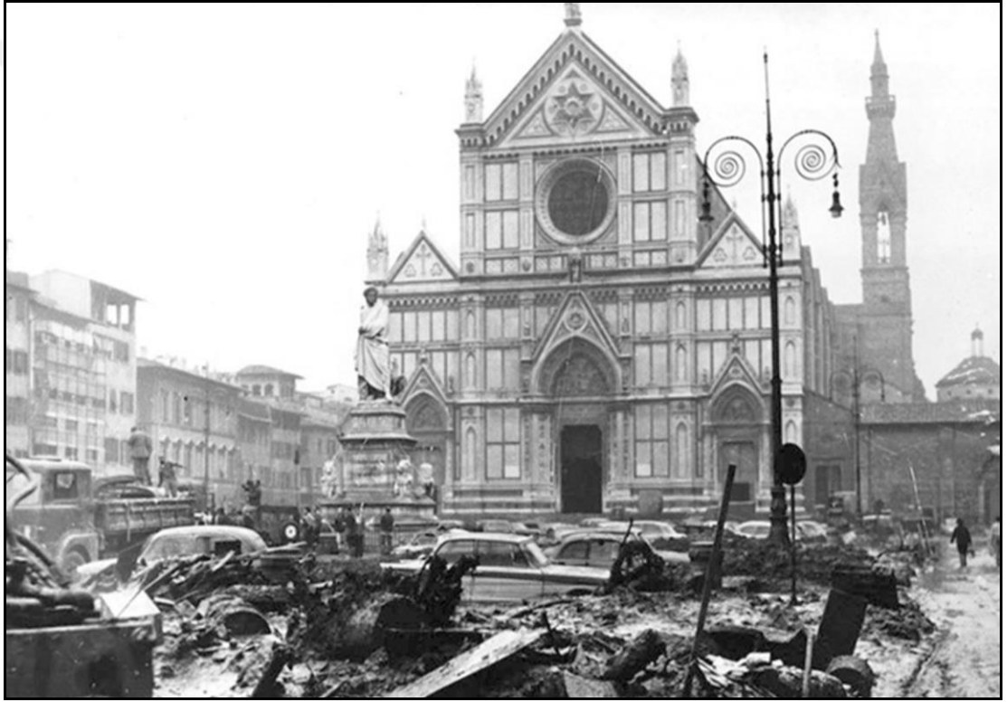
Şekil 2.14. 1966 yılında İtalya'da yaşanan sel baskını sonucu meydana gelen hasarlar (URL-16)
