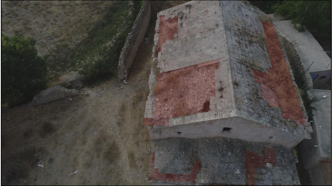
Şekil 4.6. Agios Georgios Kilisesi üst örtüsünde gözlenen malzeme kayıpları (Songur arşivi, 27.10.2020)
