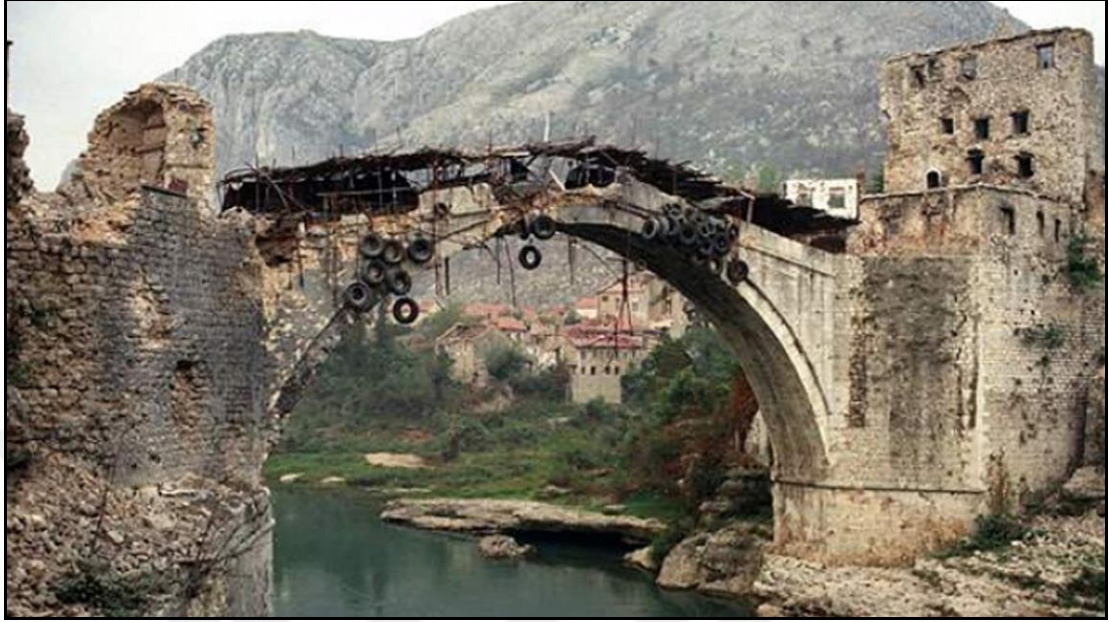
Şekil 2.18. Tarihi Mostar Köprüsü'nün savaş sırasında aldığı hasar (URL-21)
