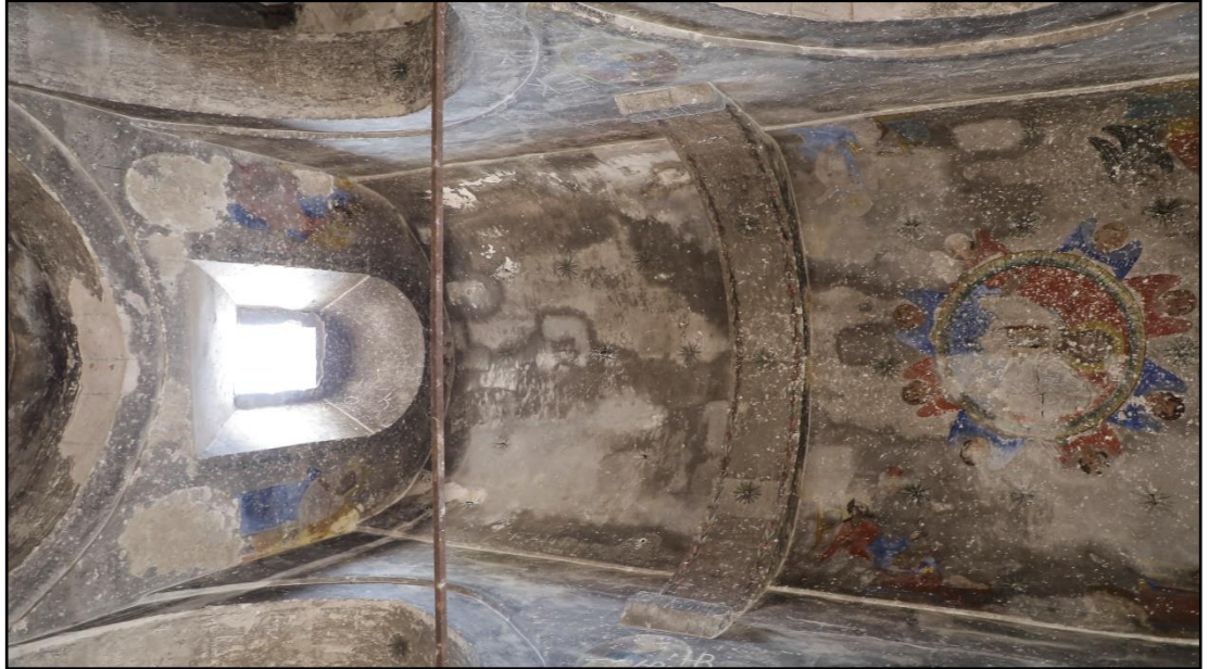
Şekil 3.30. Agios Georgios Kilisesi doğu duvarı üzerindeki pencerenin ve orta nefin beşik tonozundaki duvar resimlerinin genel görünüşü (Songur arşivi, 27.10.2020)
