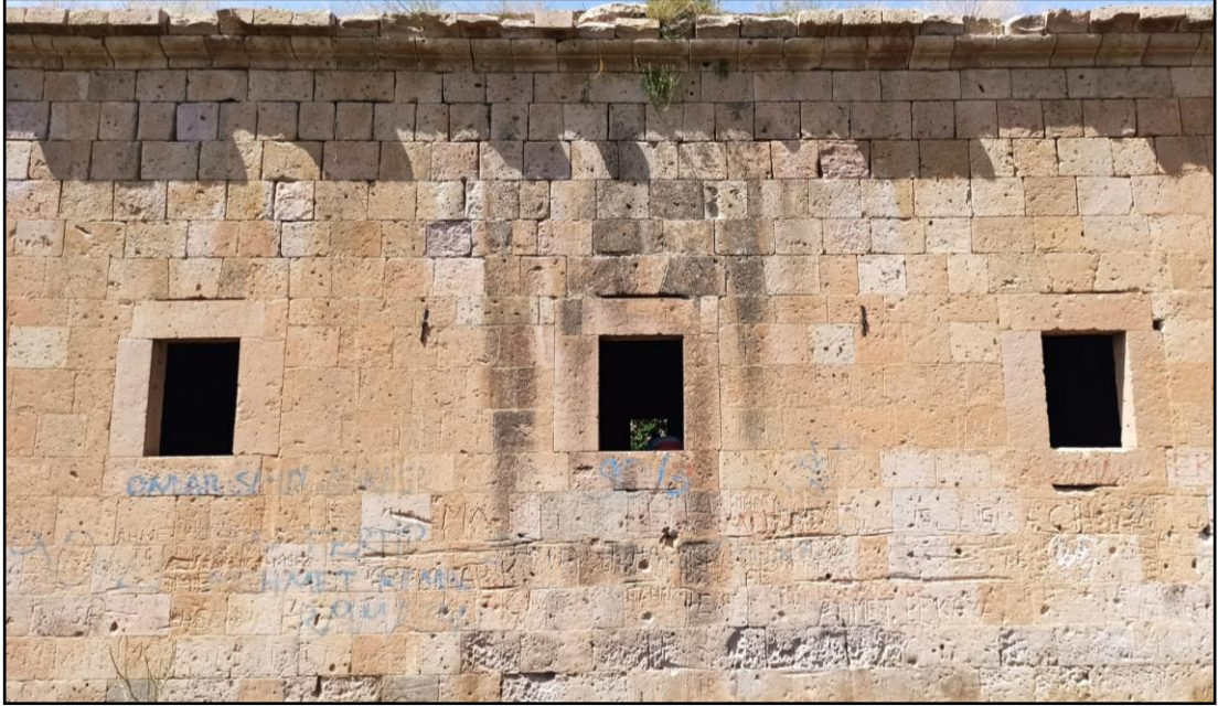
Şekil 4.1. Taş malzemede meydana gelen bozulmaların bir arada görülebildiği güney cephesi (Songur arşivi, 02.07.2021)
