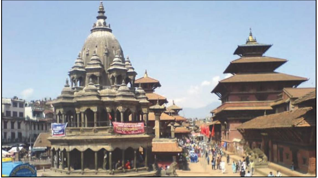
Şekil 2.12. Hanuman Dhoka'da saray ve tapınak binası deprem öncesi (UNESCO ve diğ., 2010)
