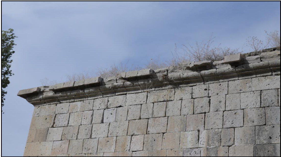
Şekil 4.35. Agios Georgios Kilisesi kısmen yok olan çatı saçağı ve buna bağlı gerçekleşen derz boşalması (Songur arşivi, 27.10.2020)
