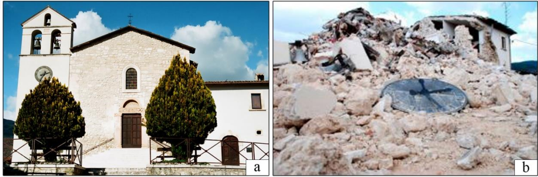
Şekil 2.9. Parish Church of Tempera; a) deprem öncesi, b) deprem sonrası (Borri ve Corradi, 2019)
