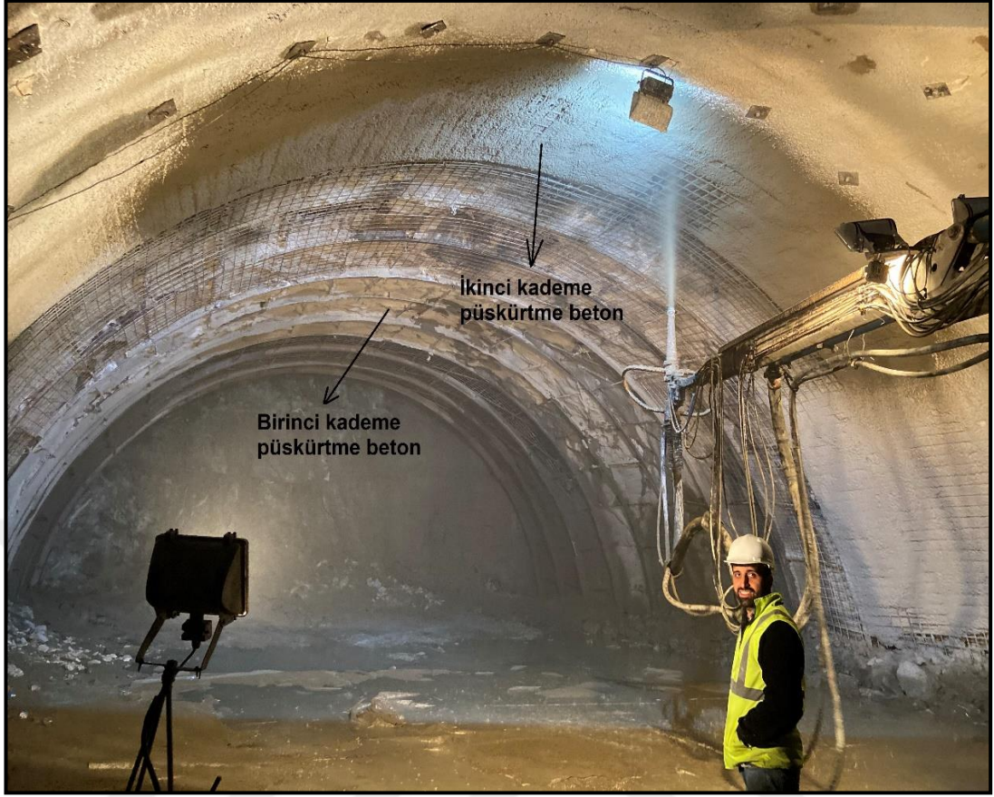
Şekil 4.13. Tünel tavan kısmında ikinci kademeye uygulanan püskürtme beton
