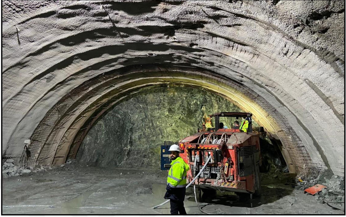
Şekil 3.3. T2 tüneli kazı aynasında metamorfik istife ait metaofiyolit düzeylerinin görünümü
