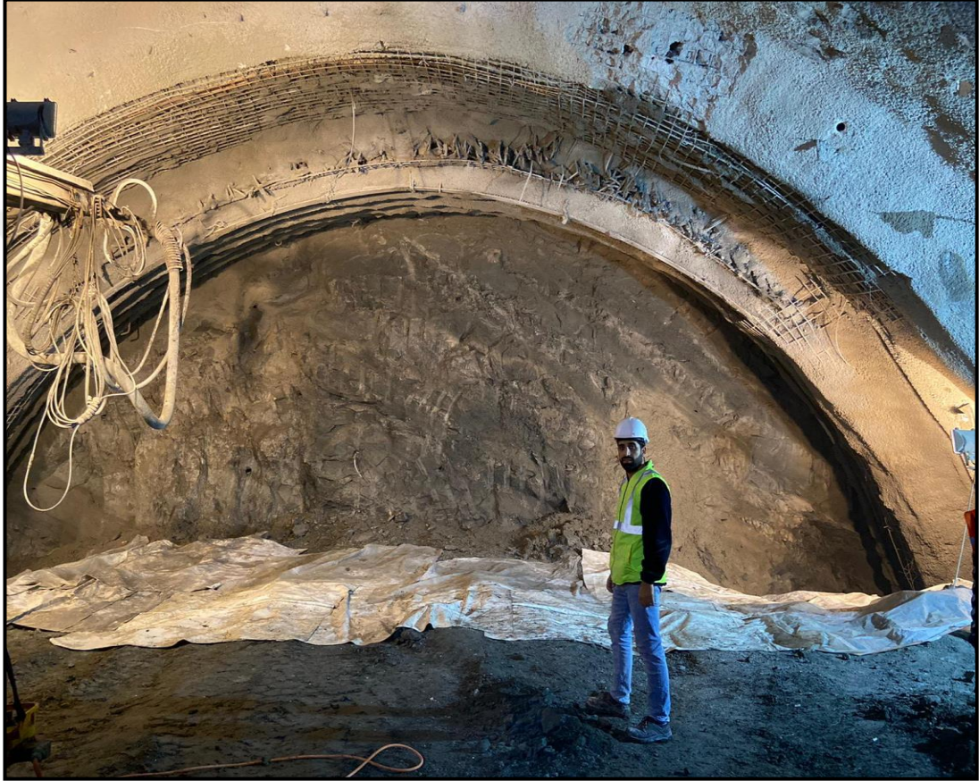
Şekil 4.12. Ribaunt takibi için tünel zemine serilen branda
