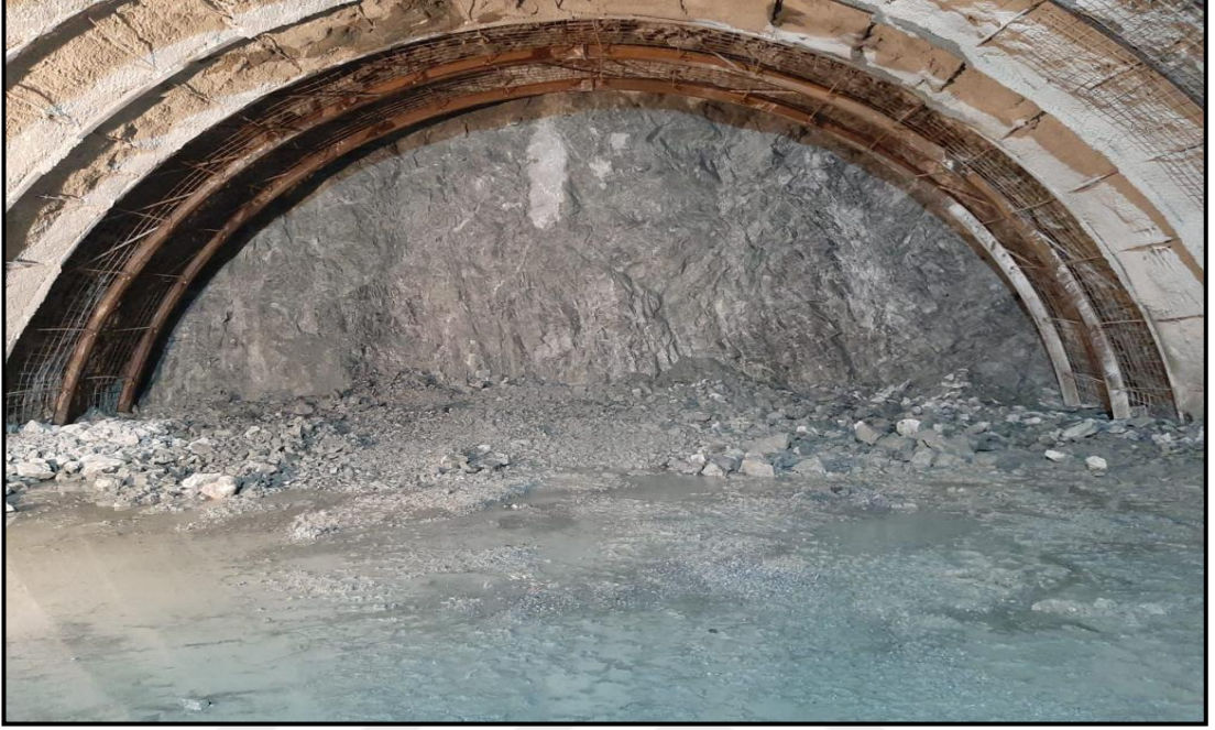
Şekil 3.1. T2 tüneli kazı aynasında metamorfik istife ait metakumtaşı düzeylerinin görünümü
