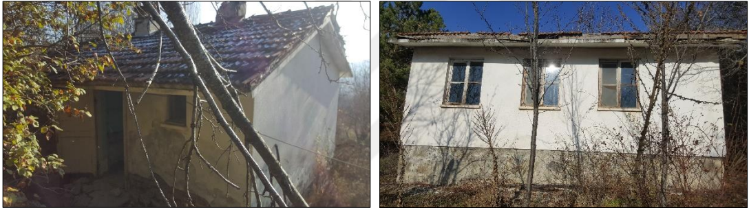
Şekil 4.61. Eğitim yapısına ait lojman – Şabanlar Mahallesi (Gümüş Yıldırım, 2019)
