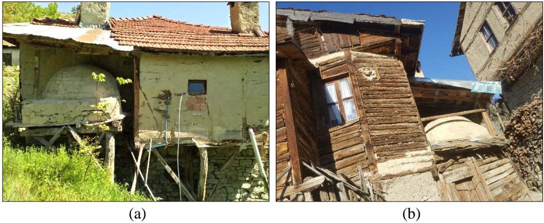
Şekil 4.39. EK-A – M10 envanter numaralı konutun mutfakla bağlantılı fırını – Merkez Mahallesi (a), EK-C – H16 envanter numaralı konutun mutfakla bağlantılı fırını – Hapşanlar Mahallesi (b) (Gümüş Yıldırım, 2019)
