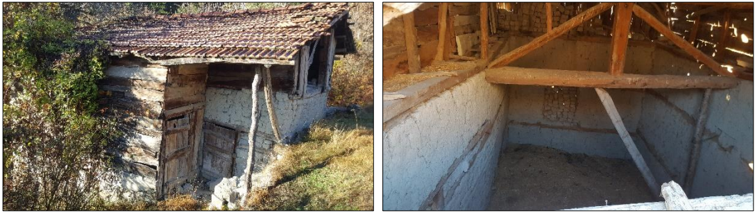
Şekil 4.50. Kullanılmayan samanlık yapısı – Merkez Mahallesi (Gümüş Yıldırım, 2019)
