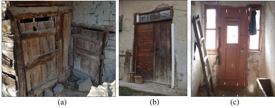
Şekil 4.92. Samanlık yapısına ait çakma tek kanatlı kapılar (a), Konut yapısına ait çakma çift kanatlı giriş kapısı (b), Konut yapısına ait çakma tek kanatlı balkon kapısı (c) – Merkez Mahallesi (Gümüş Yıldırım, 2019)
