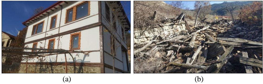
Şekil 4.18. Özgünlük durumu kötü derecede olan yapı – Şabanlar Mahallesi (a), Yıkılmış durumda olan yapı – Merkez Mahallesi (b) (Gümüş Yıldırım, 2019)
