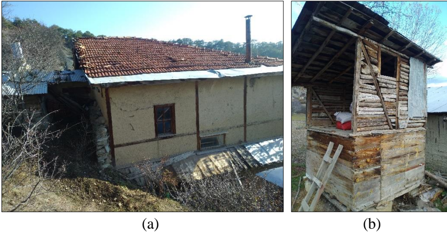
Şekil 4.90. Beşik çatı ve üç yöne eğimli kırma çatı – Şabanlar Mahallesi (a), Tek eğimli çatı – Merkez Mahallesi (b) (Gümüş Yıldırım, 2019)
