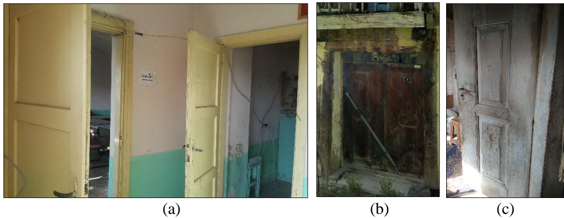
Şekil 4.93. Okul yapısına ait tablalı tek kanatlı kapı (a), Konut yapısına ait tablalı çift kanatlı giriş kapısı (b), Konut yapısına ait tablalı tek kanatlı oda kapısı (c) – Şabanlar Mahallesi (Gümüş Yıldırım, 2019)
