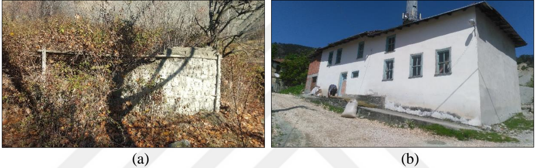
Şekil 6.12. Temel yapımına uygun olmayan kerpiç malzeme kullanımı – Merkez Mahallesi (a), Temel seviyesinde hatalı müdahale – Hapşanlar Mahallesi (b) (Gümüş Yıldırım, 2019)
