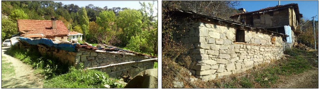
Şekil 4.79. Taş yığma sistem ile inşa edilmiş saya yapıları – Şabanlar Mahallesi (Gümüş Yıldırım, 2019)
