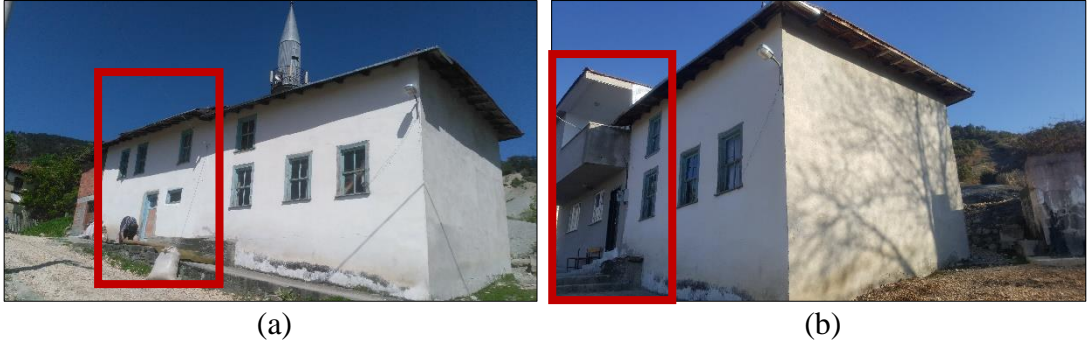
Şekil 4.71. 2019 yılında yıkılan köy odası - Hapşanlar Mahallesi (a – Gümüş Yıldırım, 2018, b – Gümüş Yıldırım, 2019)
