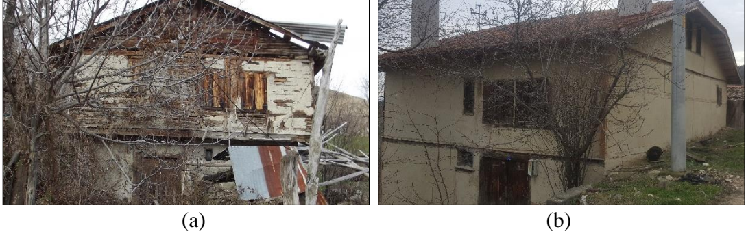
Şekil 4.97. Giyotin pencerelerin dış yüzünde yer alan ahşap kapaklar – Merkez Mahallesi (a), Şabanlar Mahallesi (b) (Gümüş Yıldırım, 2019)
