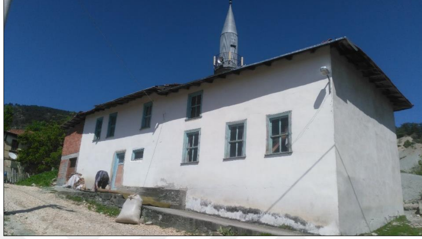
Şekil 4.68. Hapşanlar Mahallesi cami yapısı (Gümüş Yıldırım, 2018)
