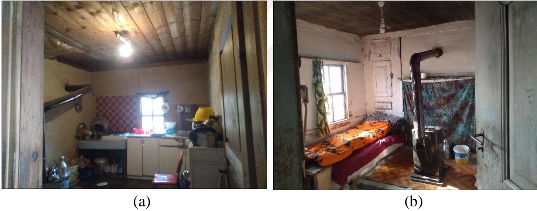
Şekil 6.10. Odanın iptal edilerek mutfığa dönüştürülmesi (a), Soba ile ocağın işlevini kaybetmesi (b) – Şabanlar Mahallesi (Gümüş Yıldırım, 2019)
