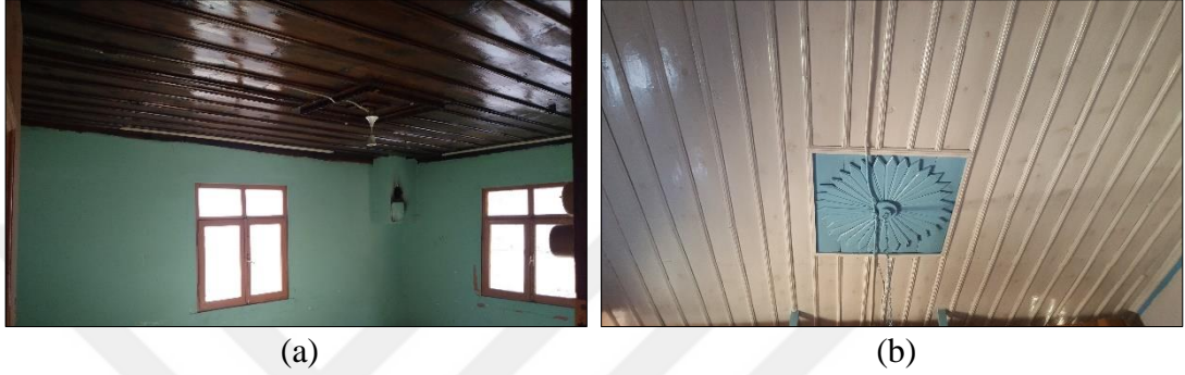
Şekil 4.86. Konut yapısı tavanında oluşturulan göbek – Merkez Mahallesi (a), Hapşanlar Mahallesi camisi tavanında oluşturulan göbek (b) (Gümüş Yıldırım, 2019)
