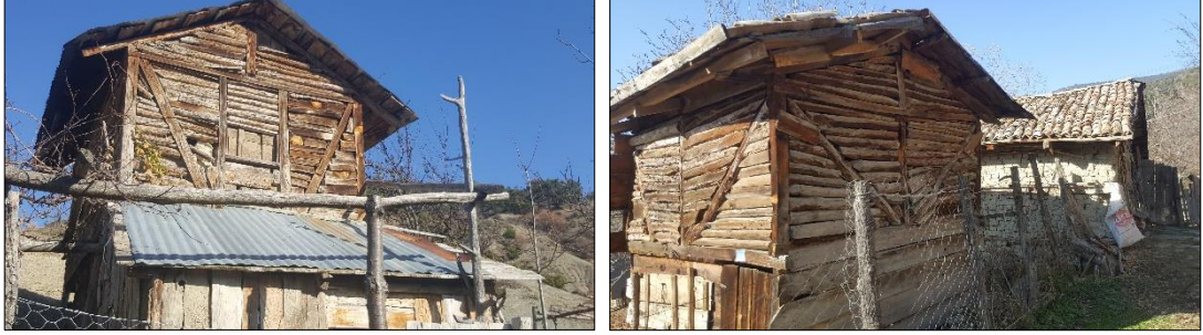
Şekil 4.81. Ahşap karkas sistem ile inşa edilmiş ambar yapıları – Hapşanlar Mahallesi (Gümüş Yıldırım, 2019)
