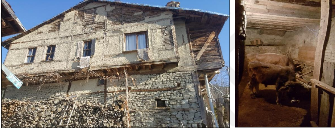
Şekil 4.53. Zemin katı ahır işlevi gören konut yapısı – Hapşanlar Mahallesi (Gümüş Yıldırım, 2019)
