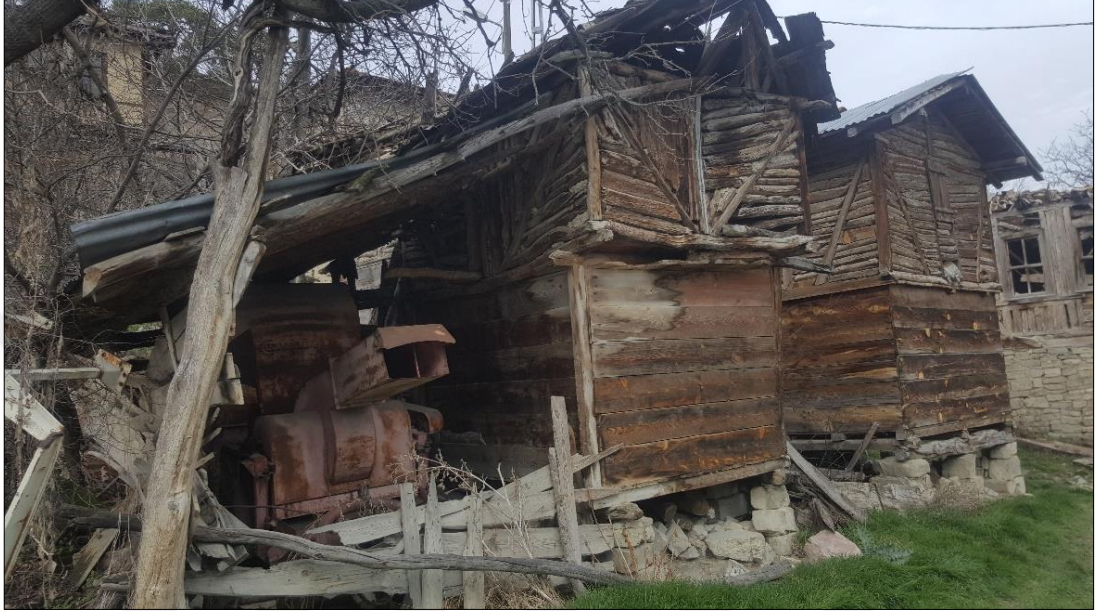
Şekil 4.52. Kullanılmayan ambar yapıları – Merkez Mahallesi (Gümüş Yıldırım, 2019)
