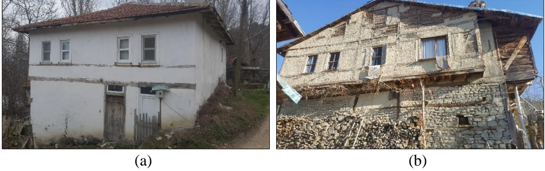
Şekil 6.15. Özgün olmayan doğramalar – Merkez Mahallesi (a), Pencere boyutunun değiştirilmesi – Hapşanlar Mahallesi (b) (Gümüş Yıldırım, 2019)
