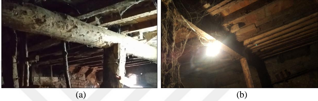
Şekil 4.84. Tavan kaplamasının yapılmadığı döşeme sistemi – Merkez Mahallesi (a), Hapşanlar Mahallesi (b) (Gümüş Yıldırım, 2019)
