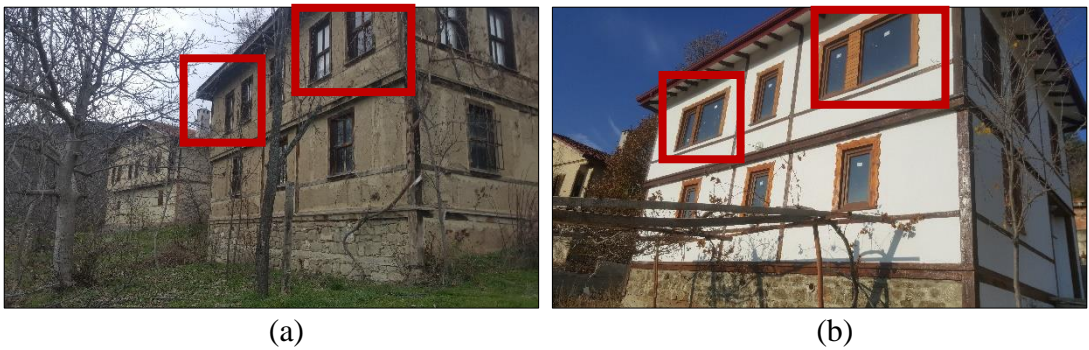
Şekil 6.9. Onarım sırasında pencere doğramalarında malzeme ve boyut olarak yapılan değişiklik – Şabanlar Mahallesi (a - Gümüş Yıldırım, 2018, b - Gümüş Yıldırım, 2019)
