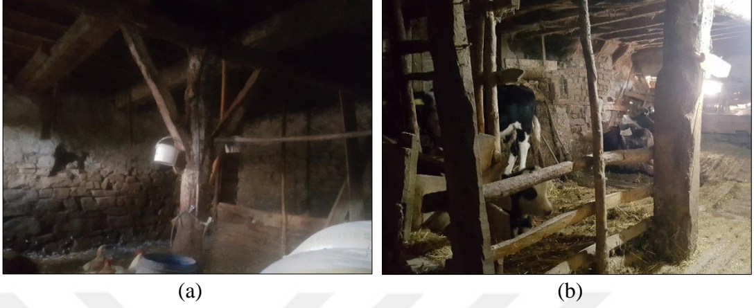
Şekil 4.33. EK-A – M10 envanter numaralı konutun ahır – Merkez Mahallesi (a), EK-A – M41 envanter numaralı konutun ahır – Merkez Mahallesi (b) (Gümüş Yıldırım, 2019)
