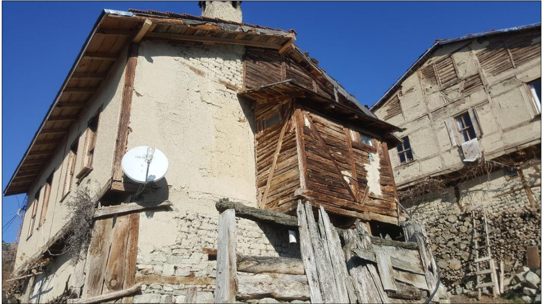
Şekil 4.47. Kısmen sıvalı konut yapıları – Hapşanlar Mahallesi (Gümüş Yıldırım, 2019)
