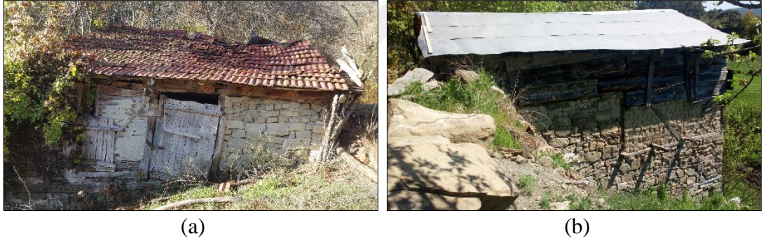
Şekil 4.27. Kiremit örtü malzemesi – Merkez Mahallesi (a), Çinko örtü malzemesi – Şabanlar Mahallesi (b) (Gümüş Yıldırım, 2019)
