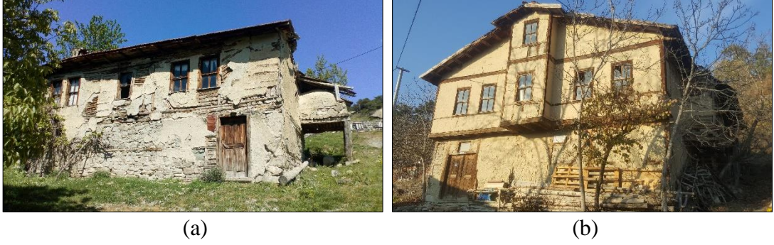
Şekil 4.45. Çıkmasız konut yapısı – Hapşanlar Mahallesi (a), Çıkmalı konut yapısı – Şabanlar Mahallesi (b) (Gümüş Yıldırım, 2019)
