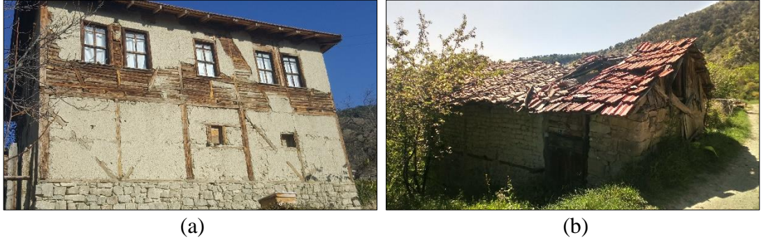
Şekil 4.13. Sağlamlık durumu iyi derecede olan yapı – Hapşanlar Mahallesi (a), Sağlamlık durumu orta derecede olan yapı – Şabanlar Mahallesi (b) (Gümüş Yıldırım, 2019)
