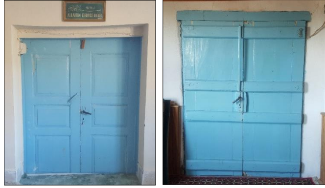
Şekil 4.94. Hapşanlar Mahallesi'ne ait karma çift kanatlı kapı (Gümüş Yıldırım, 2019)
