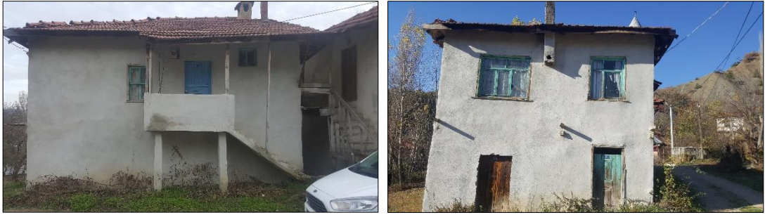
Şekil 4.70. Merkez Mahallesi köy odası (Gümüş Yıldırım, 2019)
