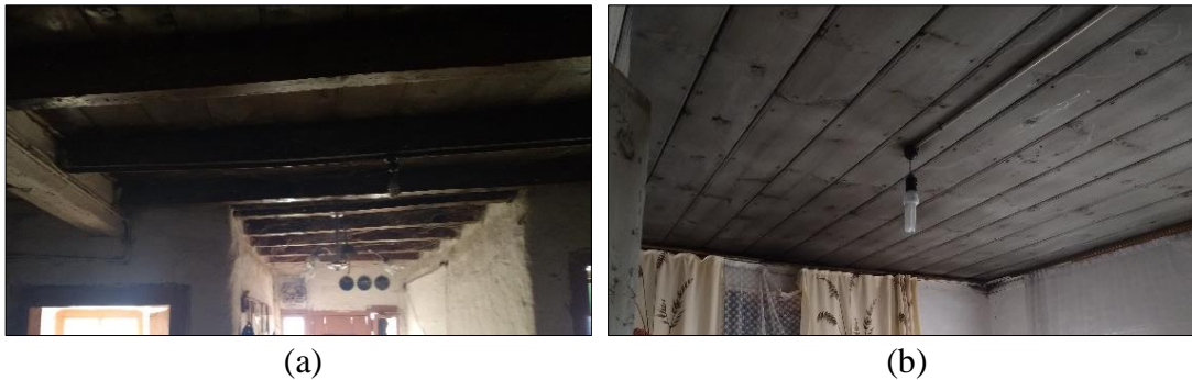
Şekil 4.85. Tavan kaplaması yapılmayan sofa mekânı – Merkez Mahallesi (a), Tavan kaplaması yapılan oda mekânı – Şabanlar Mahallesi (b) (Gümüş Yıldırım, 2019)
