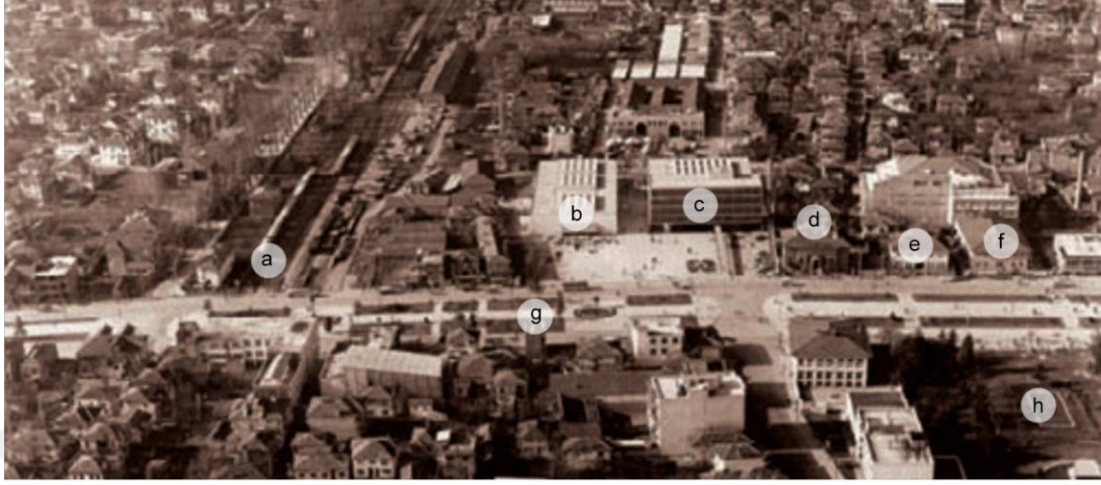
a İstasyon rayları b Adliye Binası
