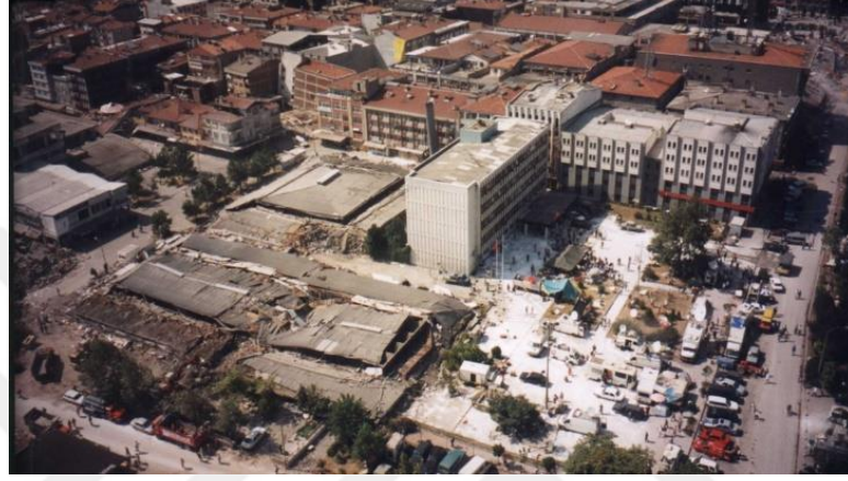
Şekil 3.7. 1999 Marmara depreminde yıkılan Adapazarı Vilayet Binası ve çevre binalar (URL-3)
