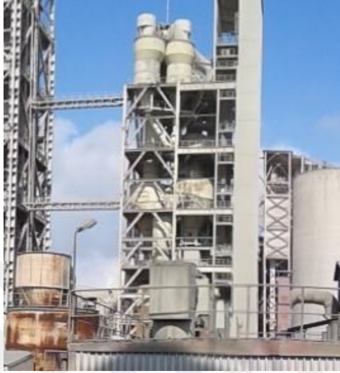
Şekil 5.1. Ön ısıtıcı siklonları genel görüntüsü
