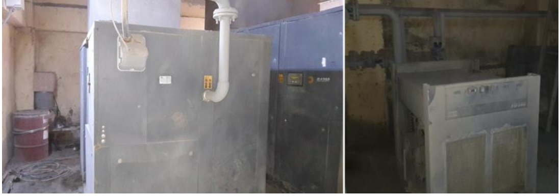
Şekil 4.6. 1 ve 2. Çimento değirmeni atlas copco GA110 model kompresör (solda) ve kurutucusu (sağda)
