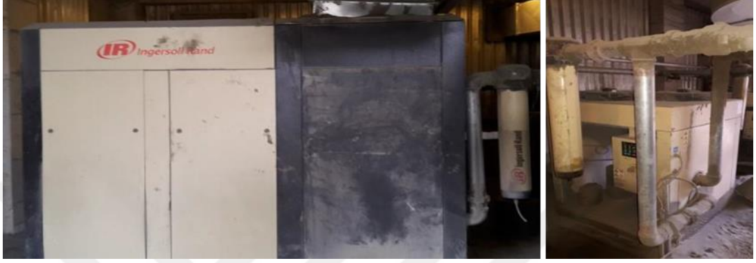
Şekil 4.7. 4. ve 5. Çimento değirmeni 2 nolu Ingersoll Rand marka kompresör (solda) ve kurutucusu (sağda)
