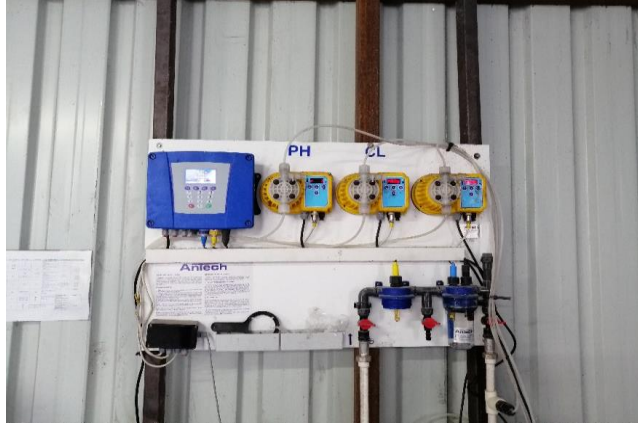
Şekil 4.11. Otomatik kimyasal dozajlama ünitesi
