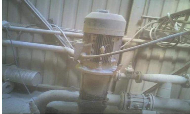
Şekil A.6. Soğutma pompa-motor grubu
