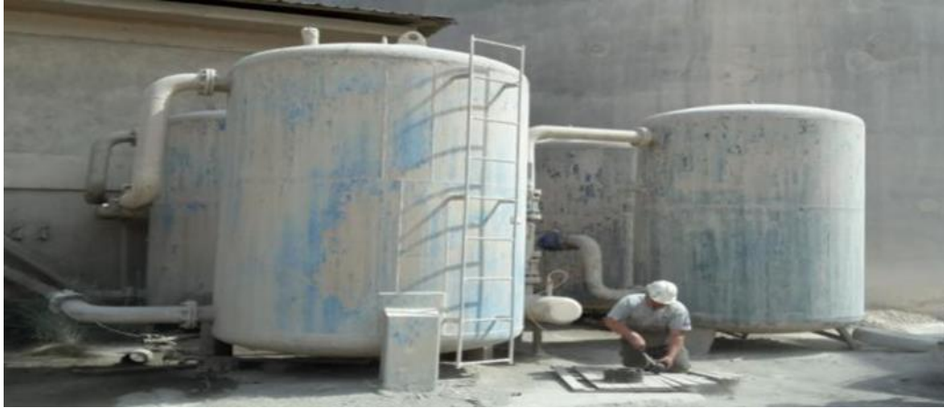
Şekil 4.5. 1. Hat döner fırın yanı kompresör dairesi basınçlı hava tankları (4 adet)
