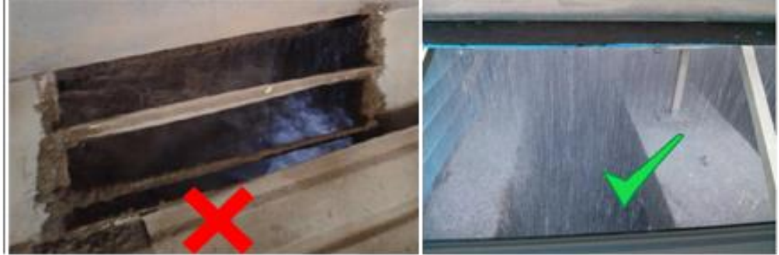
Şekil 4.16. 1 ve 2 Teknolojik havuz soğutma kulesi su dağılımı (solda) ve uygun olan su dağılımı örneği (sağda)
