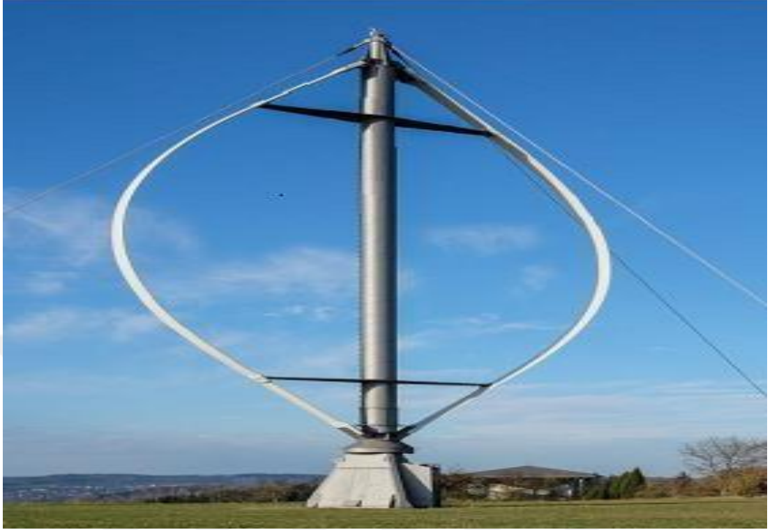
Şekil 1.23. Darrieus tip dikey eksenli rüzgâr türbini [46].
