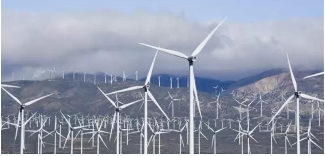
Şekil 1.21. Üç kanatlı yatay eksenli rüzgâr türbini [46].
