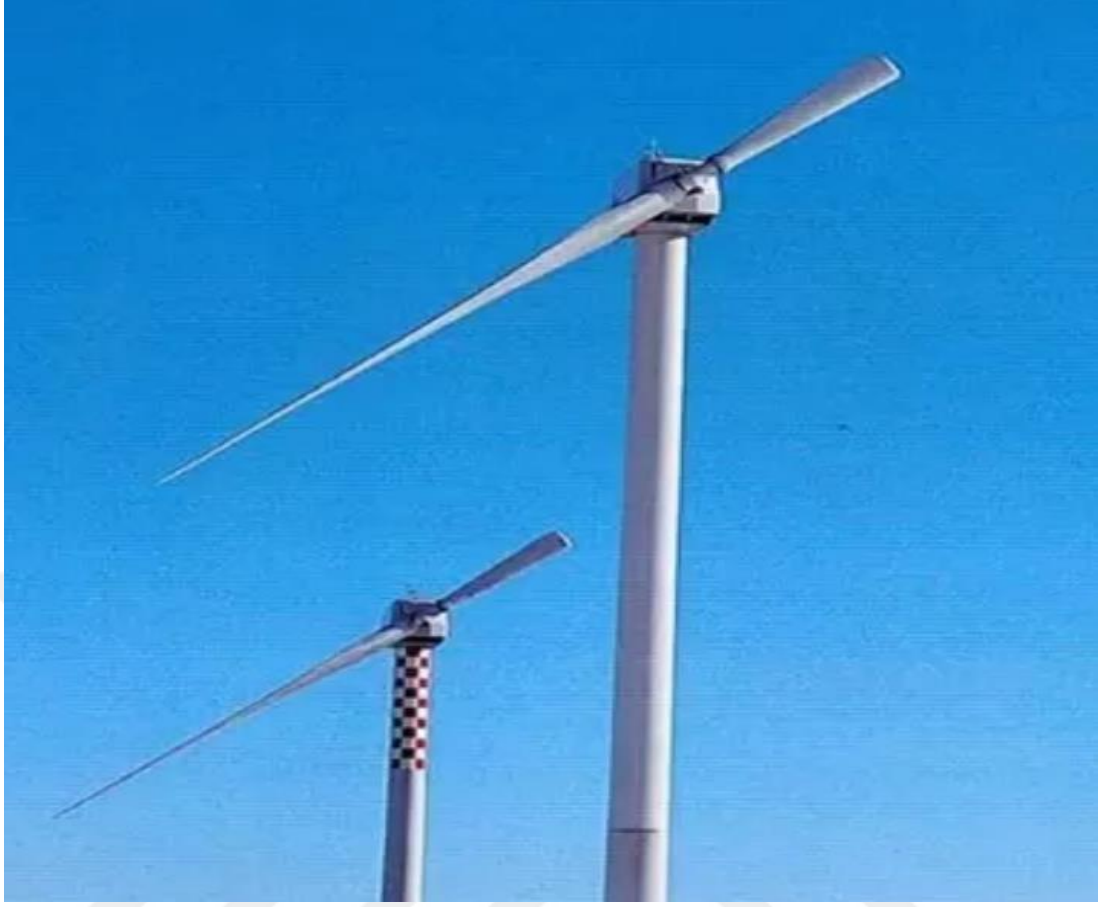
Şekil 1.19. Tek kanatlı yatay eksenli rüzgâr türbini [46].
