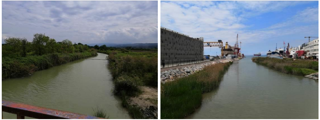
Şekil 2.7. Yalacdere Mansap Noktasının (YD3) Kuzey (sol görsel) ve Güney (sağ görsel) istikametlerinden görünümü
